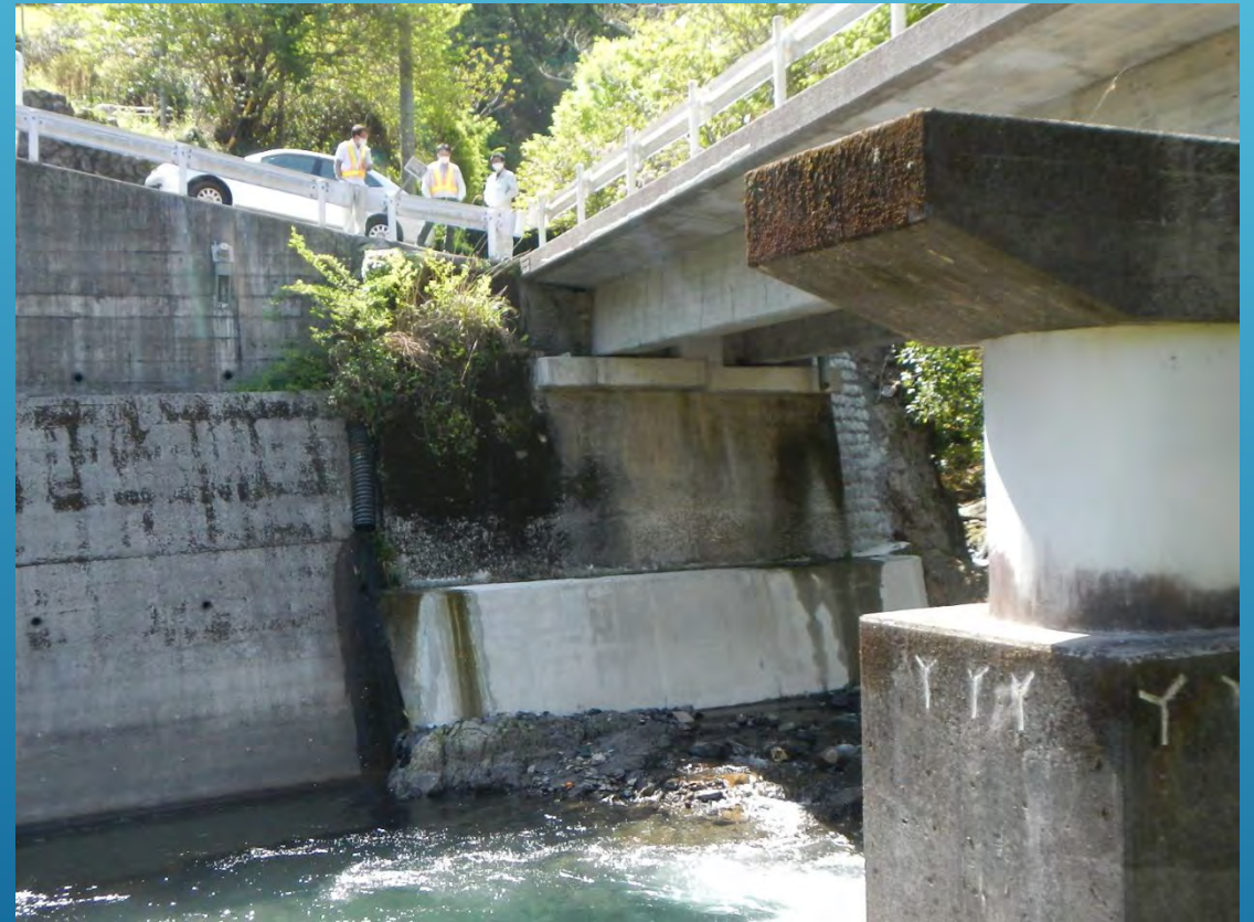
補修後の写真
