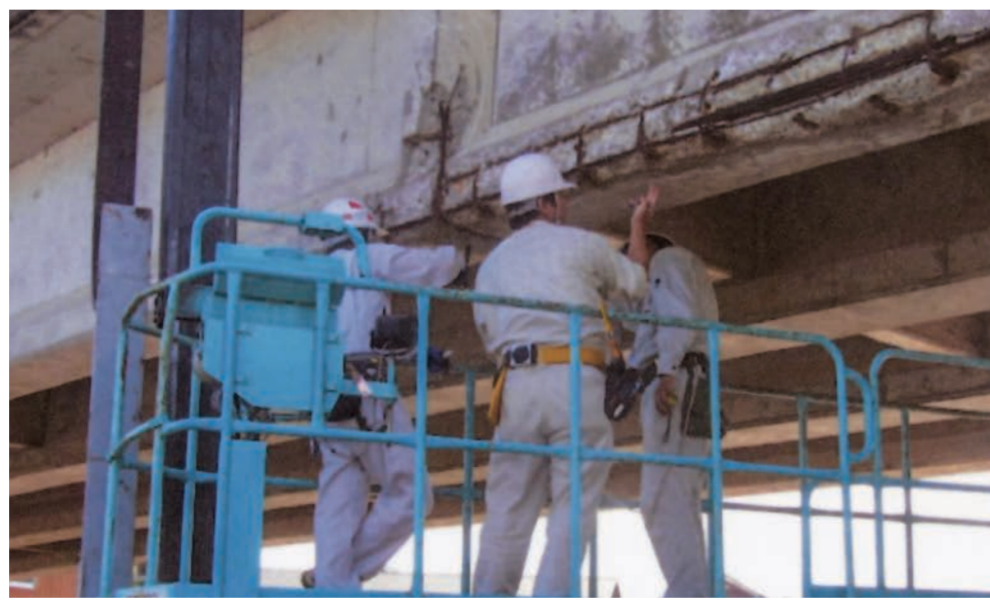
目視による橋梁点検
