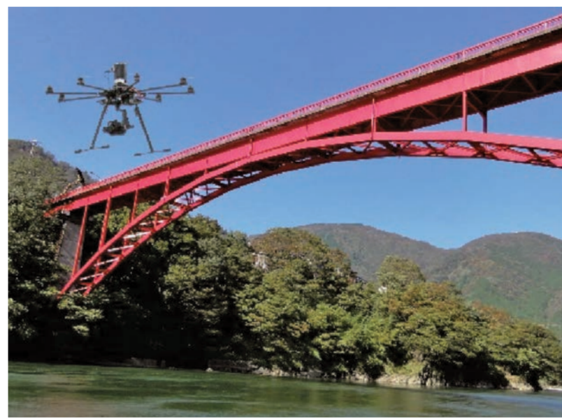
ドローンによる橋梁点検
