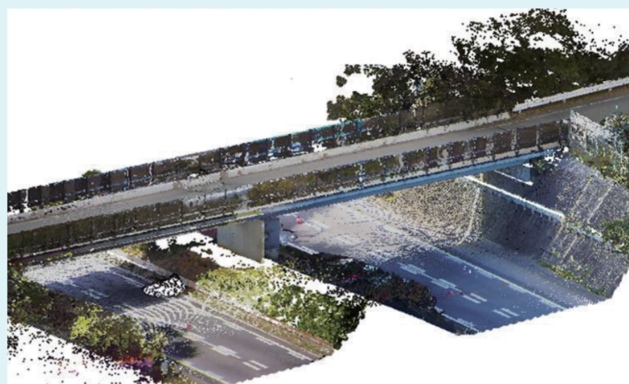
地上型レーザスキャナにより取得された3次元データ
